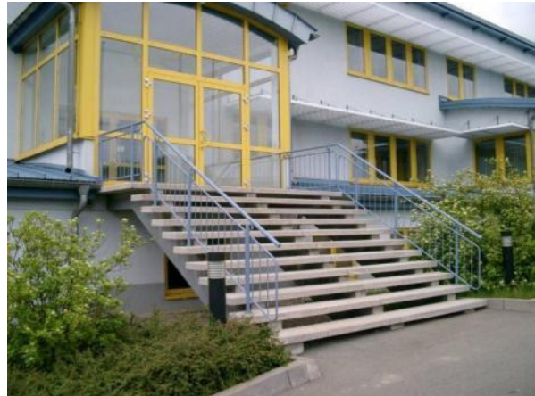
Bauvorhaben: autoTEC, Oederan
