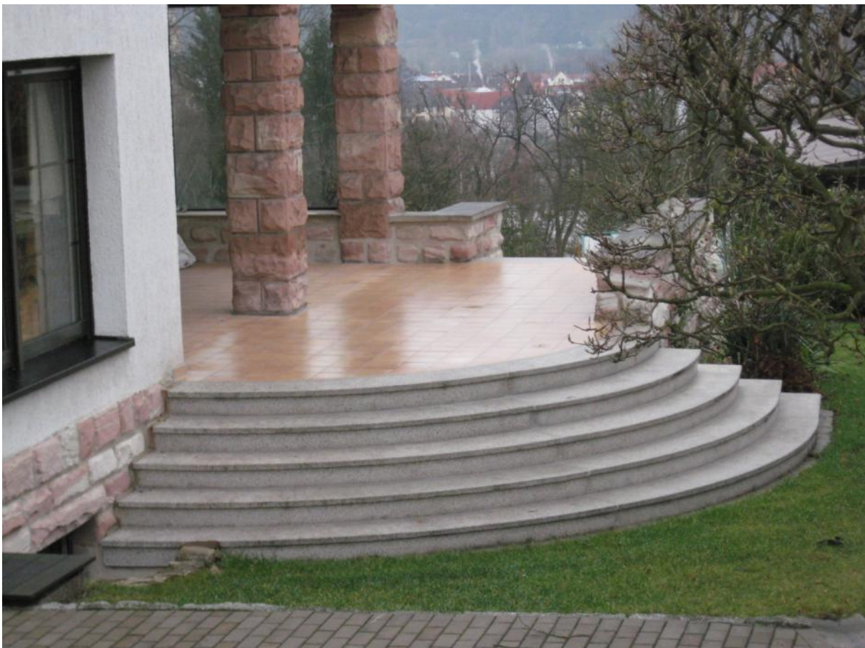
Bauvorhaben: Terrassenaufgang WH in Bad-Salzburgen
