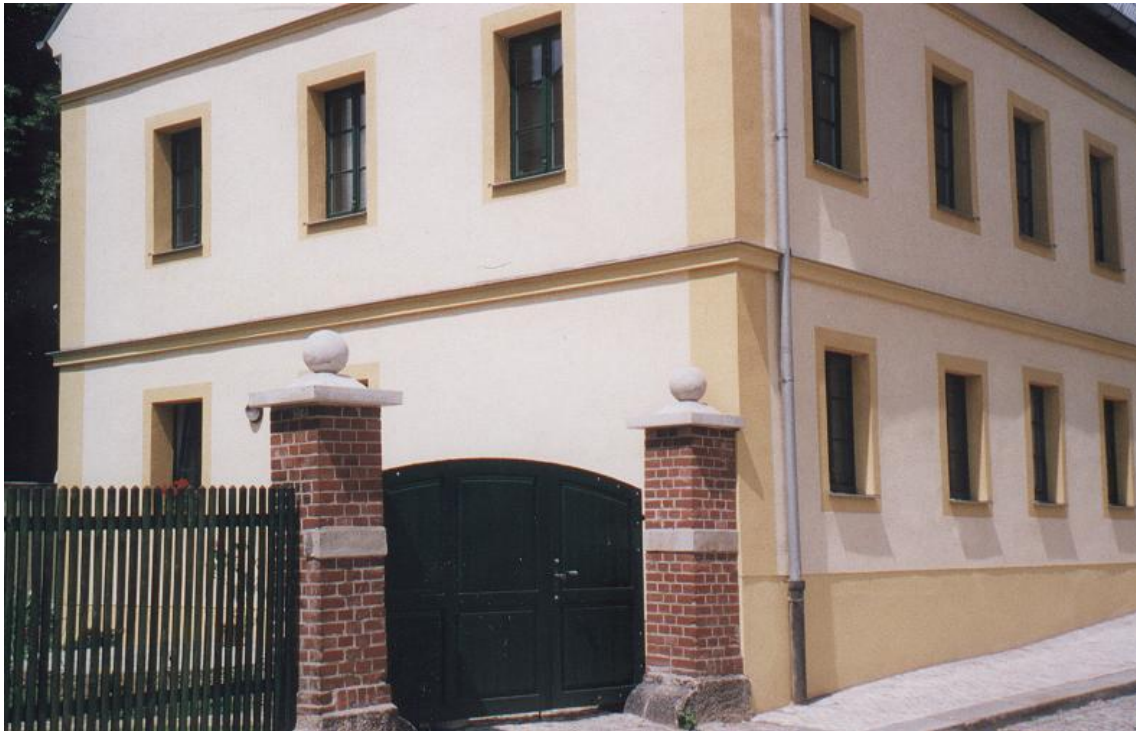
Bauvorhaben: ehemaliger Schlachthof Oederan
