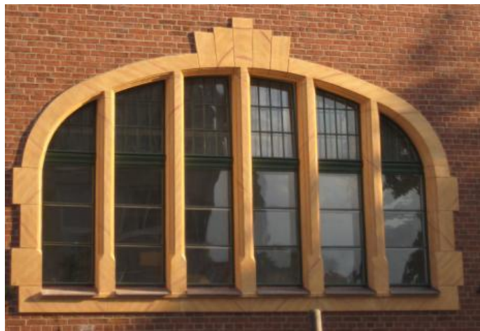
Material: Stahlbeton Fenstergewände mit nachträglicher Farbbeschichtung
