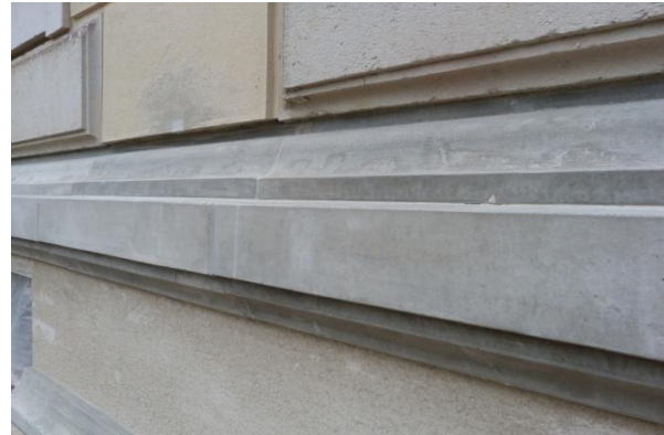
Material: Stahlbeton - Sockelgesimselemente
