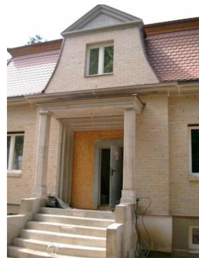
Material: Sichtbeton Türgewände, Gesimsteile, Ziergiebel und Vordach mit Stahlbetonstützen
